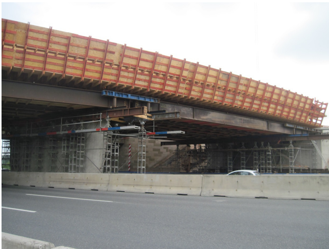
Abbildung: Traggerüst der Brücke Weinstraße mit eingeschalttem Überbau
